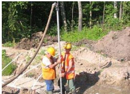
يتم تركيب هذا النظام بسرعة وسهولة وهذه أهم ميزة فيه فيتم توصيل الحربة بطلمية لضغط المياه (تعطي ضغط حولي ٦ بار وتصرف ٢٠ لتر/ث) ويتم غرسها في التربة فتنزل الحربة في الأرض بسهولة جدا تحت تأثير ضغط المياه التي تخرج من أسفل الحربة والتي تجعل الرمل في حالة غليان وطالما كانت التربة رملية تسمى يسمى نزول الحربة
