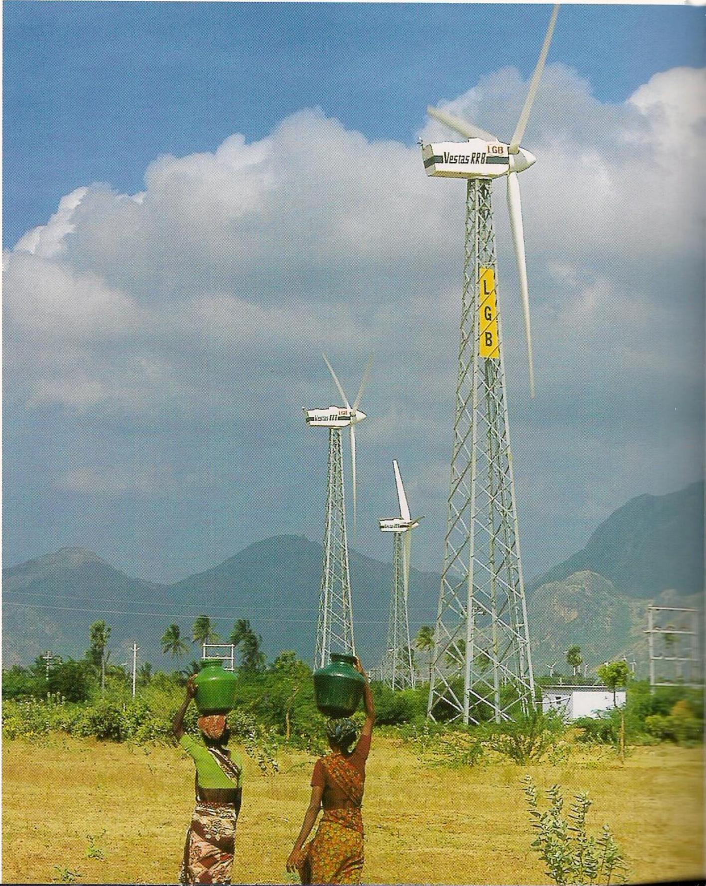
أقامت الشركة الدانمركية، فيستاس، أكثر من 600 تُّربين هوائي في الهند. وقد دُرب السُكَّان المحليون على إقامة تلك التُّربينات واستخدامها وإصلاحها. إن الأبراج الفولاذية المكشوفة التي تحمل التُّربينات هي أسهل تصنيعًا وإقامةً من الأبراج الخرسانية.
