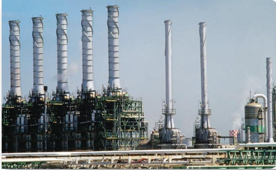
■ **الشكل 7** تقوم أبراج التقطير التجزيئي بفصل كميات كبيرة من النفط إلى مكونات قابلة للاستخدام. إن الآلاف من المنتجات التي تستخدمها في منازلنا، وفي النقل، وفي الصناعة هي من نواتج تكرير النفط.
