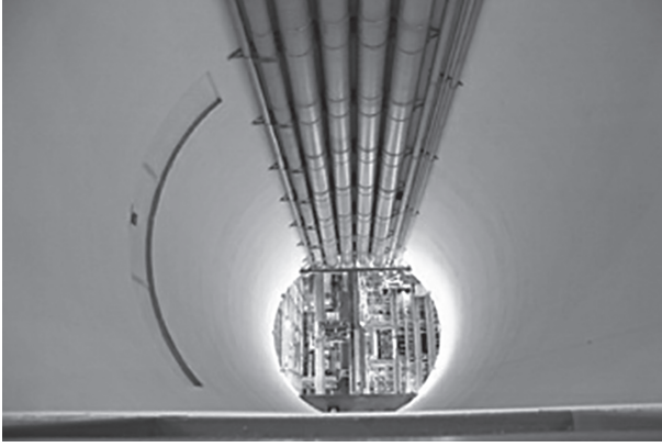
شكل ١٣-١: مشهد لما يمكن رؤيته عند النظر لأسفل من على المنصة الموجودة أعلى حفرة تجربة كاشف أطلس. وتظهر بالشكل الأنبابيب التي نقلت المواد إلى أسفل الحفرة.
