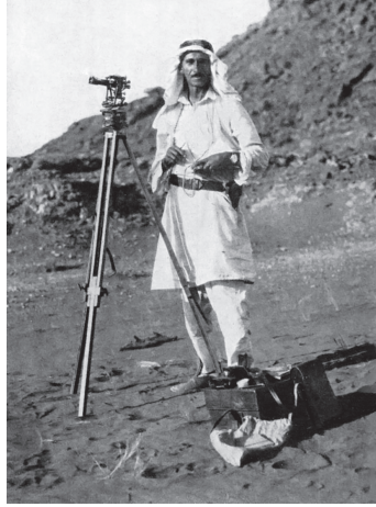
الرحالة يرصد الشمس بألة التيودوليت.
