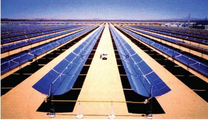
شكل ١١: مركزات ذات حوض قطع مكافئ في كرامر جنكشن، كاليفورنيا: هذا النظام، الذي يُدعى «نظام توليد الكهرباء من الطاقة الشمسية» موجود في كرامر جنكشن بصحراء موهافي بكاليفورنيا، منذ عام 1984. وهو يُعد أكبر مولد للكهرباء من الشمس في العالم. وسعته الإجمالية 354MW. انظر الفصل الحادي عشر - قسم (٤).
