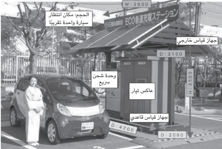
شكل ١٢-١٠: محطة شحن سيارات كهربائية تعمل بالطاقة الشمسية في كيوتو: محطة الشحن، التي قدمتها شركة نيسين إلكتروك المحدودة، مزودة بحزمة بطاريات وعاكس تيار ووحدة شحن سريع. الصورة معروضة بإذن من جامعة كيوتو.
