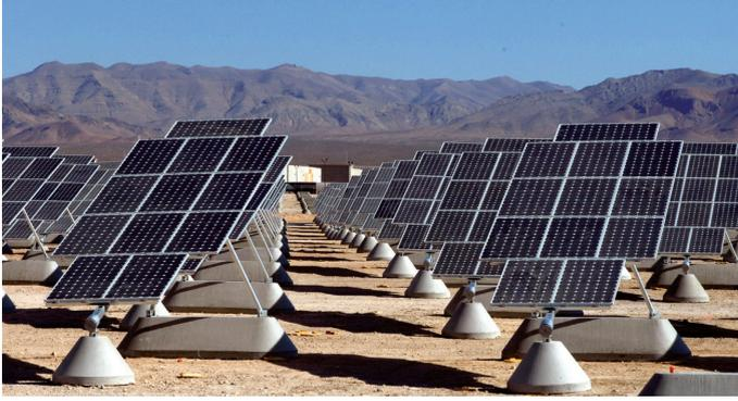
شكل ٦: خلايا شمسية مصنوعة من السيليكون البلوري ذات آلية تتبع أحادية المحور: محطة نيليس للطاقة الشمسية، الموجودة داخل قاعدة نيليس للقوات الجوية في مقاطعة كلارك، بنيفادا، سعتها 14MW تقريبًا. ويمكن أن يزيد نظام تتبع شمسي أحادي المحور بسيط من قدرة الخرج بمقدار 60 بالمائة مقارنةً بنظام التوجيه الثابت القياسي؛ انظر الفصل الرابع - قسم (٣-٤). الصورة معروضة بإذن من القوات الجوية الأمريكية.
