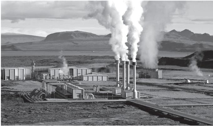
شكل ١-٢١: محطة نسجافلير للطاقة الحرارية الأرضية، أيسلندا. نظرًا لأن أيسلندا غنية بالبراكين النشطة، فلديها ميزة غير عادية فيما يتعلق باستخدام الطاقة الحرارية الأرضية العميقة. موضح بالصورة محطة نسجافلير للطاقة الحرارية الأرضية التي سعتها 120MW.
