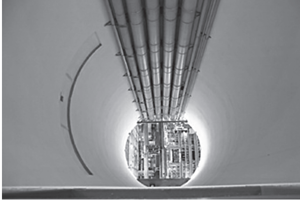
شكل ١٣-١: مشهد لما يمكن رؤيته عند النظر لأسفل من على المنصة الموجودة أعلى حفرة تجربة كاشف أطلس. وتظهر بالشكل الأنايب التي نقلت المواد إلى أسفل الحفرة.
