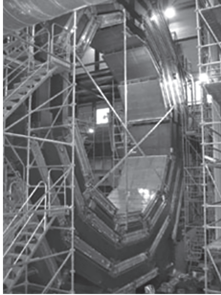
شكل ١٣-١٠: بكرة الارتداد المغناطيسية في اللولب المركب للميونات متشابكة مع كاشف الميونات (الصورة توضح جميع الأجزاء وهي تحت الإنشاء).
